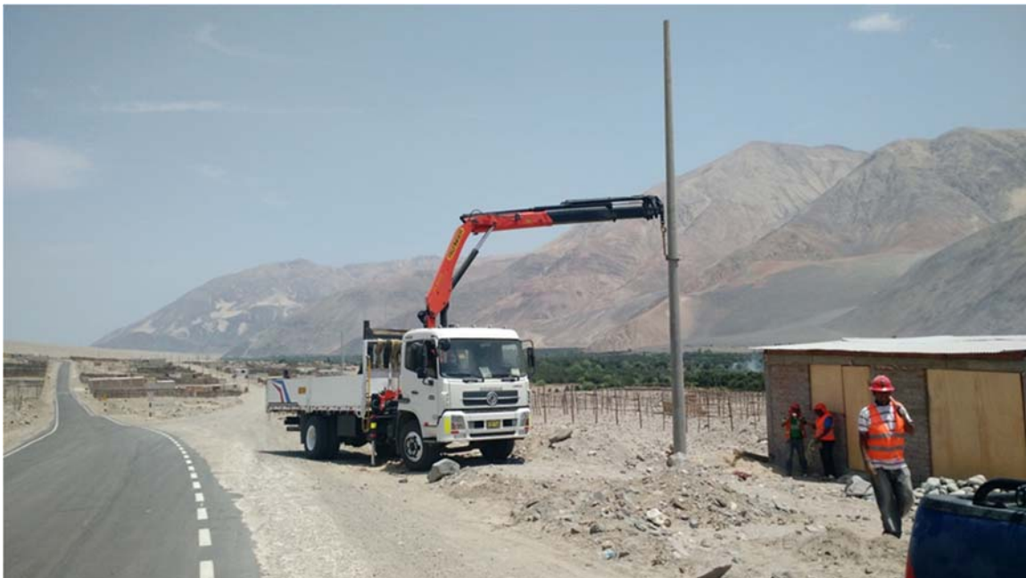
Foto 3: Instalación de postes en el tramo de la carretera Jaqui-Planta de procesamiento
